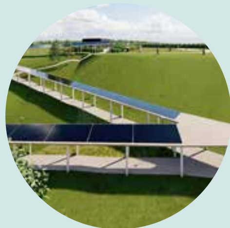
Reningsverket Margretelund Oktober
